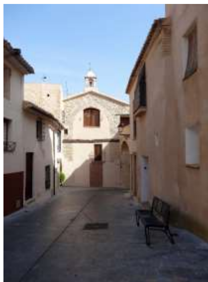
Figura 10.- Fachada de la ermita vista desde el Carrer del Delme.
